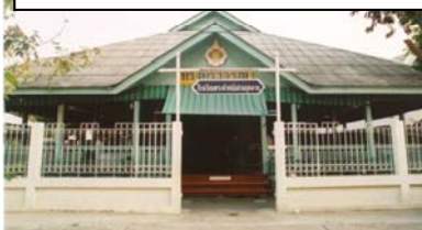
อาคารโรงโขน
